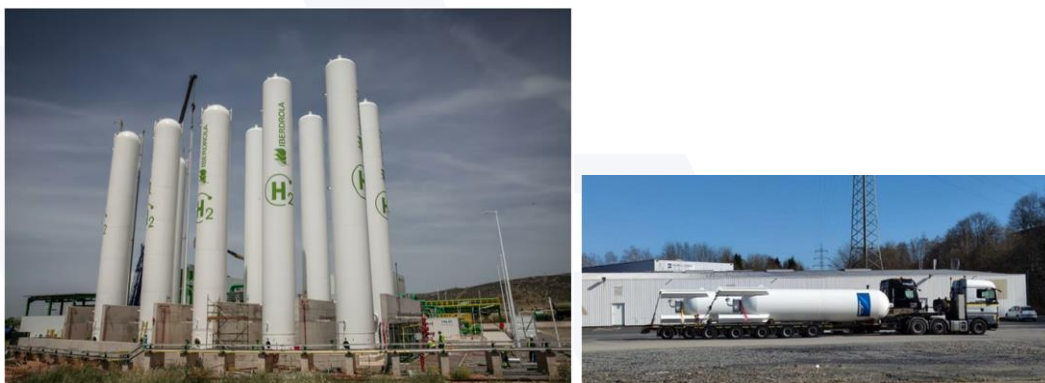
Figur 3-1: Bilder på de vätgaslager som är utgångspunkten för kostnadsuppskattningen, där 60 bars lagret visas till vänster och 200 bars lagret visas till höger.
